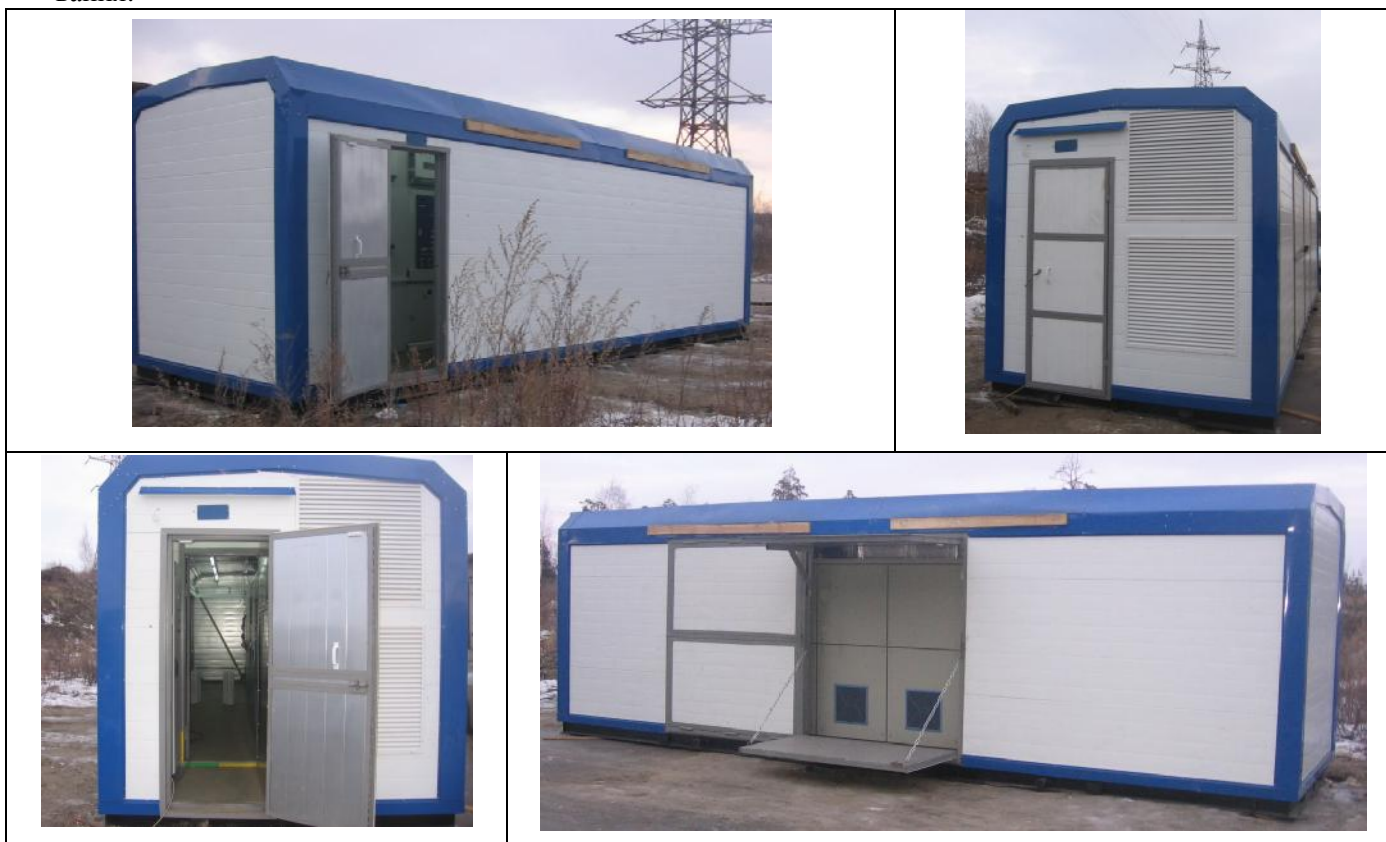
Пример размещения ВПЧА в мобильном здании контейнерного типа.
