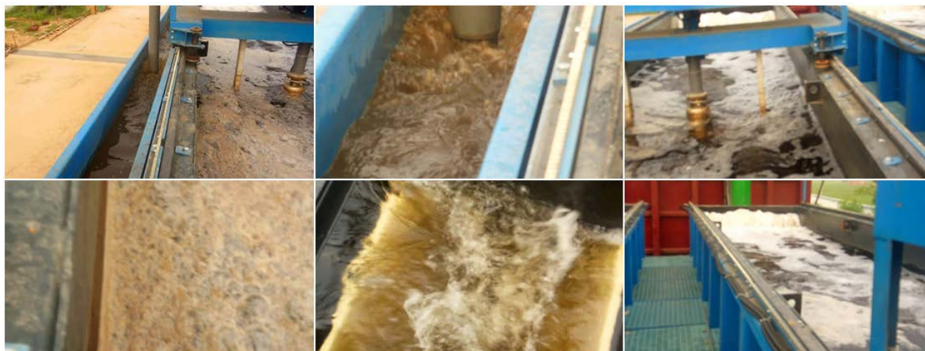
Рис. № 12. Фото ВПК ТФ в мобильном контейнере
